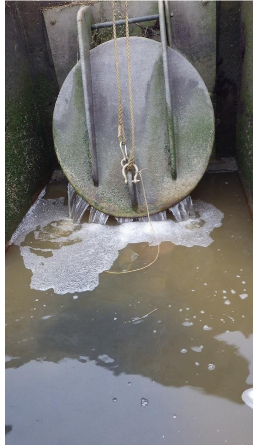
Fig. 31 Des clapets à marée limitent la remontée des anguilles sur le marais du Purgatoire
