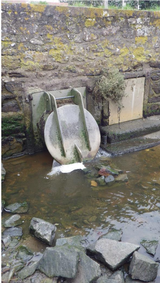
Fig. 31 Des clapets à marée limitent la remontée des anguilles sur le marais du Purgatoire
