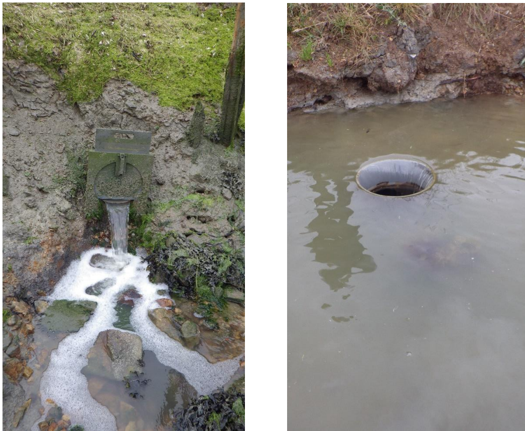
Fig. 28 un ouvrage à marée empêche la remontée des anguilles sur le marais de Pusmen
