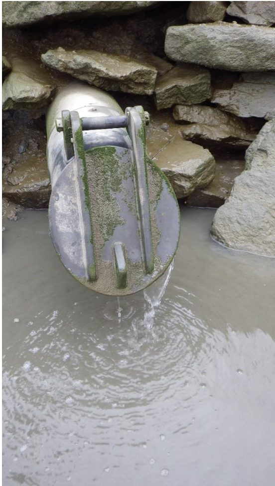
Fig. 26 Le site présente 3 ouvrages à marée qui pénalisent la remontée des poissons migrateurs
