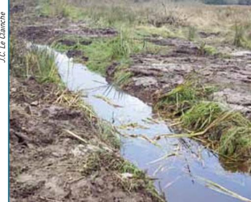
Frayère de la Cascade : les travaux 2012 ont consisté à débroussailler la végétation et créer l'amorce du bras de jonction avec le Blavet.
