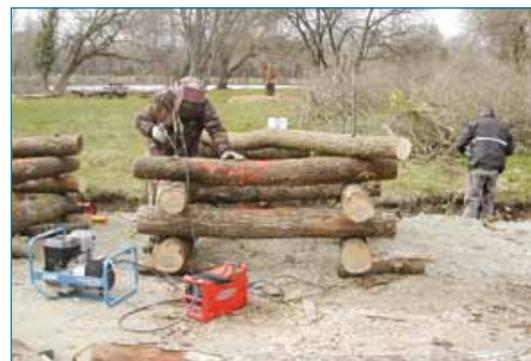
Les caissons sont montés sur place par les bénévoles de l'AAPPMA "la société du Loch" et les salariés de la Fédération de pêche du Morbihan avant d'être mis à l'eau au moyen d'une pelleteuse et immergés au milieu du plan d'eau.
