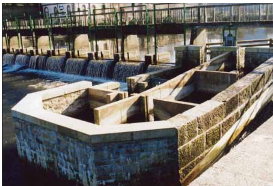
La passe à poissons du Grand Barrage à Hennebont avant sa mise en eau. Grâce à l'équipement de 10 barrages, le Blavet retrouvé son rôle de "route des affluents".
