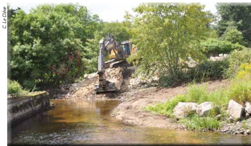
Fin des travaux : la pelleteuse reconstruit la berge au pied de l'ancien moulin abattu. A gauche, on aperçoit la brèche principale réalisée dans le barrage.
