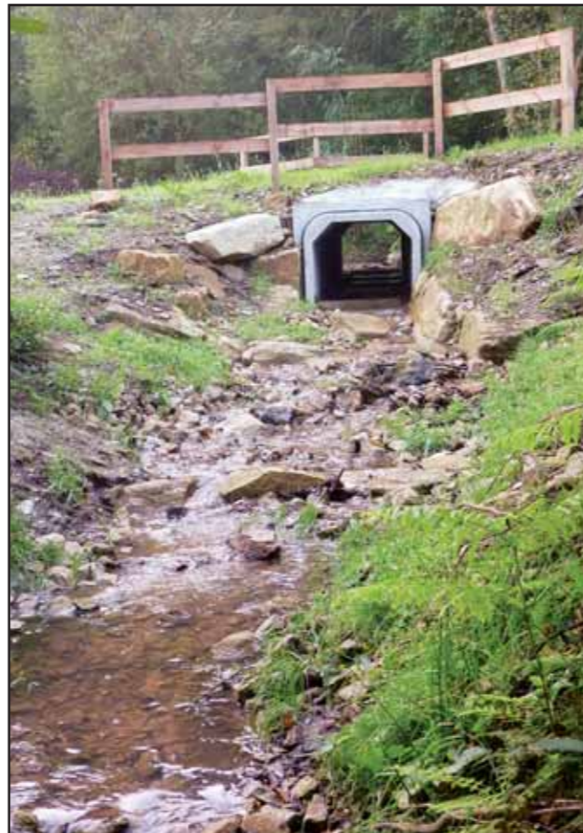
La buse de 500 mm, totalement infranchissable pour les géniteurs issus du Sedon a été remplacée par un pont cadre de 1000 x 1000 mm associé à une rampe d'enrochement en aval.
