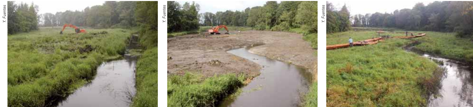
Moins de 4 mois après les travaux, la nature reprend ses droits. Il est déjà difficile de visualiser l'ancien tracé rectiligne de cette portion du Langonnet.
