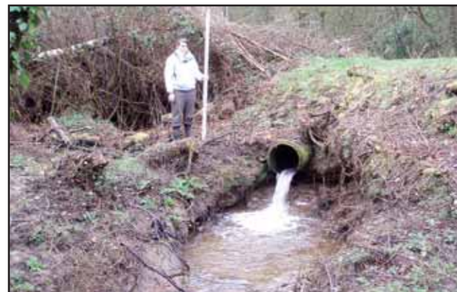
La buse de 500 mm, totalement infranchissable pour les géniteurs issus du Sedon a été remplacée par un pont cadre de 1000 x 1000 mm associé à une rampe d'enrochement en aval.
