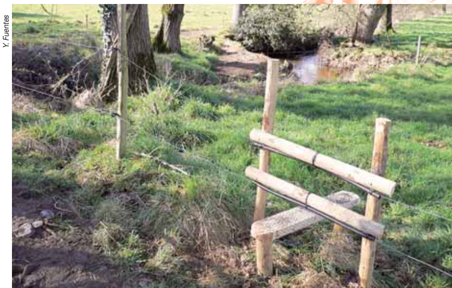
Le principe de l'enjambeur est particulièrement adapté pour le franchissement de clôtures électriques.
