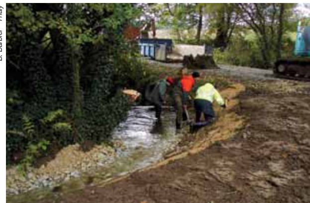
Pose d'une protection de berge en finition d'une rampe d'enrochement.
