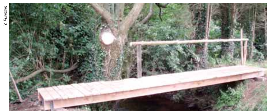
La technicité mise en œuvre dans ce projet a parfois été conséquente comme l'illustre ce pont réalisé sur le parcours du Lay, d'une portance totale de 6 mètres.
