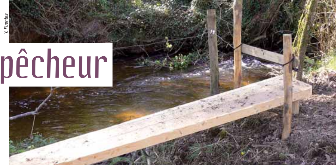
L'aménagement de passerelles rustiques permet de franchir facilement des petits affluents ou autres fossés, rendus difficilement franchissables par des hauteurs de berges excessives et que seuls les pêcheurs les plus sportifs peuvent franchir sans risquer d'y laisser un morceau de canne à pêche ou même pire !
