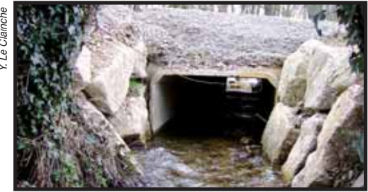
Grâce au remplacement d'une buse infranchissable, les géniteurs de saumons peuvent désormais remonter sur le ruisseau des Korrigans.
