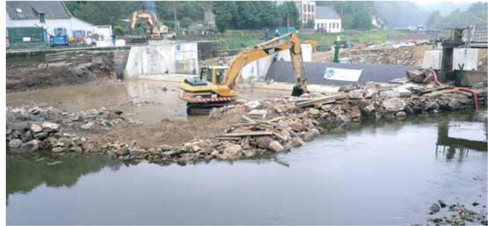
Symbole de cette alternance crues-sécheresses: les bas débits de 2005 ont facilité l'exécution des travaux d'installation des vannes à clapet, comme ici au grand barrage à Lochrist sur le Blavet.
