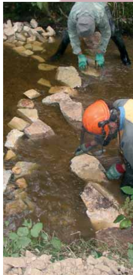
Ce seuil en cours d'élaboration créera à terme une véritable unité de vie pour la truite, en reconstituant une alternance radier/pool.
