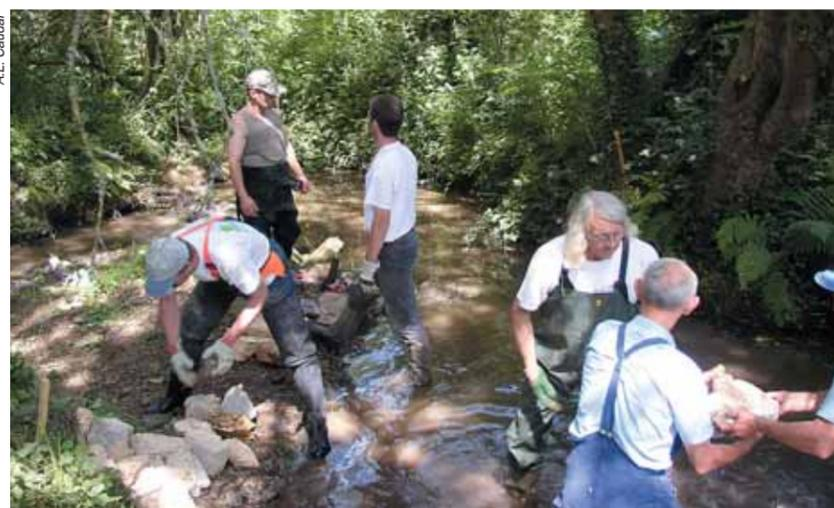
Sur la Drayac, les blocs ont été déposés par les bénévoles de la Gaule Muzillacaise de façon à recréer la diversité radier-fosse qui existait avant les travaux hydrauliques.
