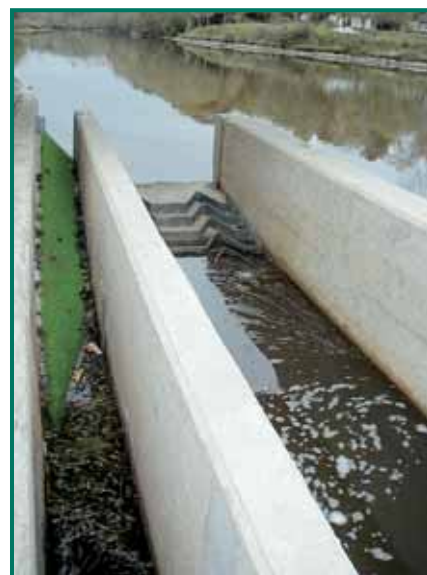
Deux nouvelles passes, avant mise en eau, qui ouvrent la porte de l'Oust aux poissons migrateurs.
