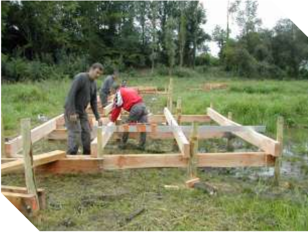
Aménagement de 3 surlargeurs pour observation
