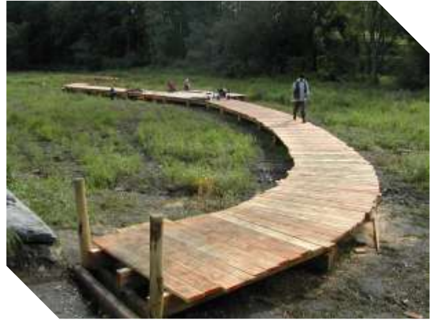
Mise en place de la couverture
