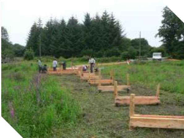
Montage de la structure porteuse
