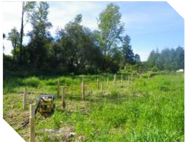
Mise en place de 200 pieux de châtaignier
