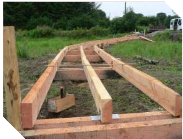
Montage des pannes porteuses de la couverture
