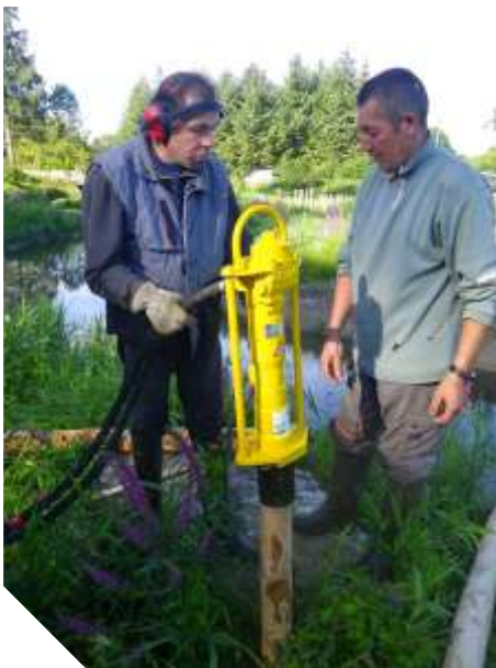
Utilisation d'un enfonce pieux hydraulique
